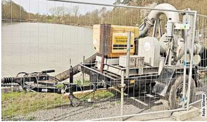
Derzeit wird das Wasser vom kleinen in den großen See hinübergelassen.
