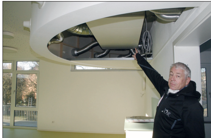
Mittels Wärmerückgewinnung werden die Gruppenräume mit gewärmter Frischluft versorgt. Für Gerhard Eller ist dies ein wichtiges Element des energetischen Konzepts in der neuen Kinderkrippe. Foto: M. Rebhan
