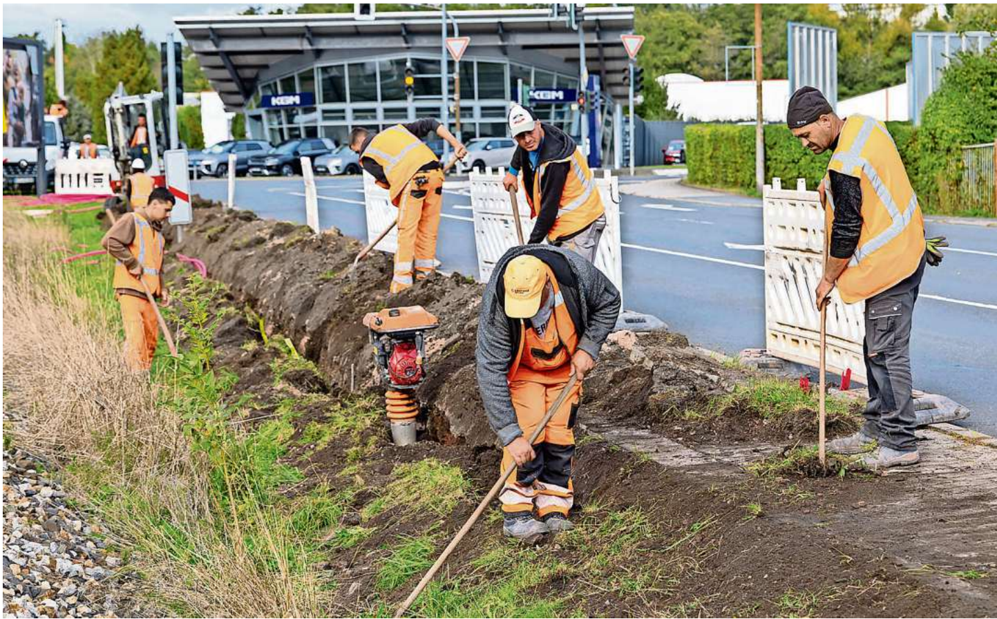
In der Suhler Straße in Schleusingen ist ein Baurupp der Firma Netz Intelligenz Deutschland am Wirken. Es geht schnell voran. Foto: Steffen Ittig
